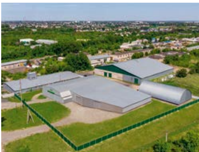
Семенной завод ООО «СибАгроЦентр» – это более 10 000 кв. м складских и производственных площадей. Семена отправляются в 38 регионов России и Казахстана
