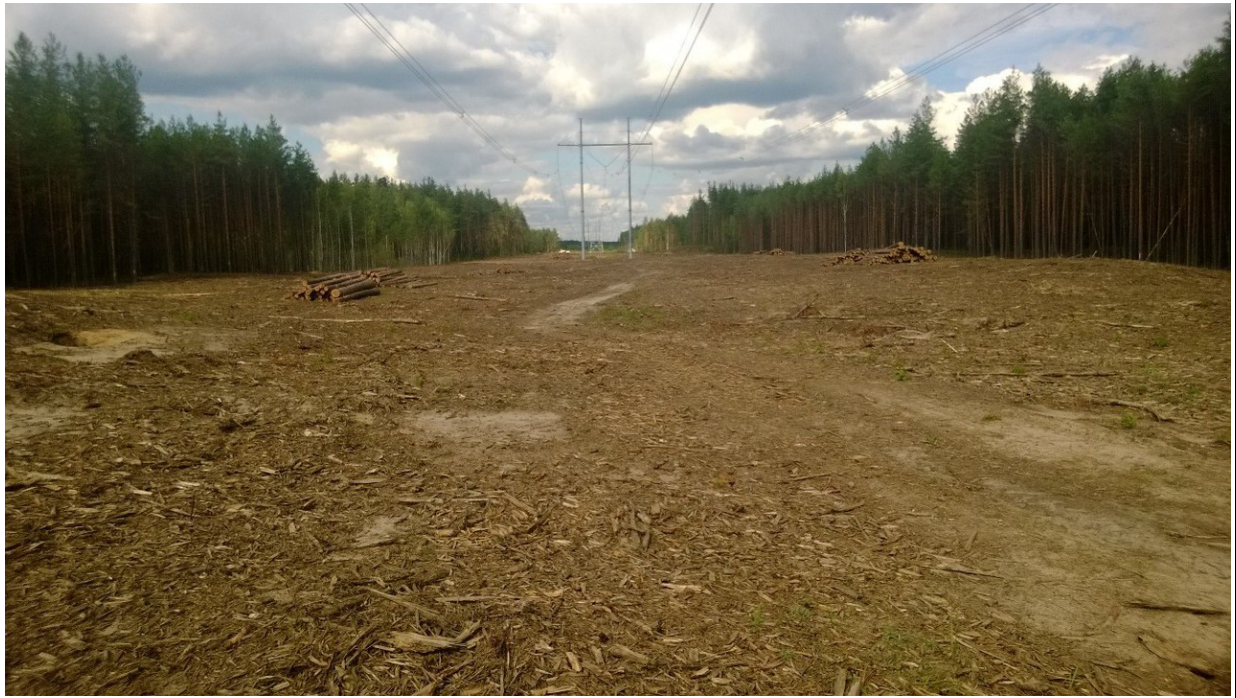
Рис.1. Внешний вид просеки после прочистки методом мульчирования
