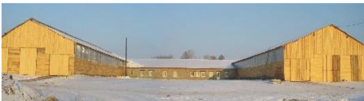
Рисунок 4 – Ферма из деревянных несущих и ограждающих конструкций на 400 коров на глубокой несменяемой соломенной подстилке в агрохолдинге Камарчагский Красноярского края
