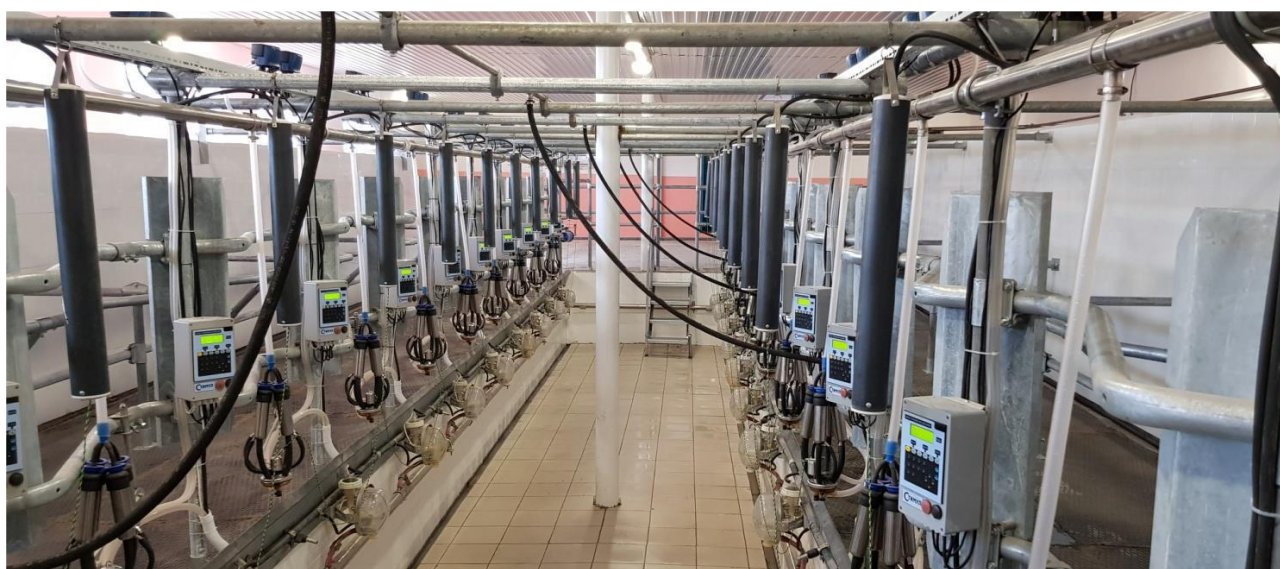
Рисунок 8 – Доильный зал с блоками управления доением (доильный зал СХП «Ярыш»)
