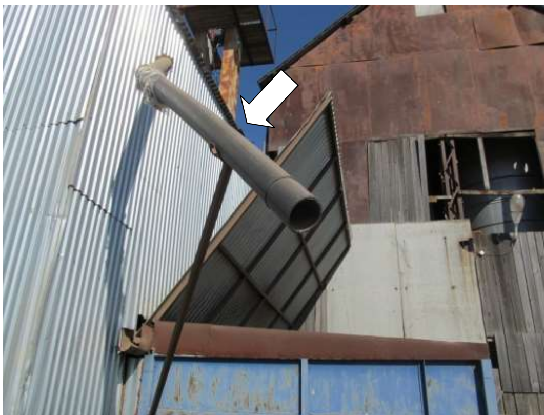
Рисунок 2 – Пример использования полимерных труб в ООО «Андрееский» Уржумского района Кировской области
