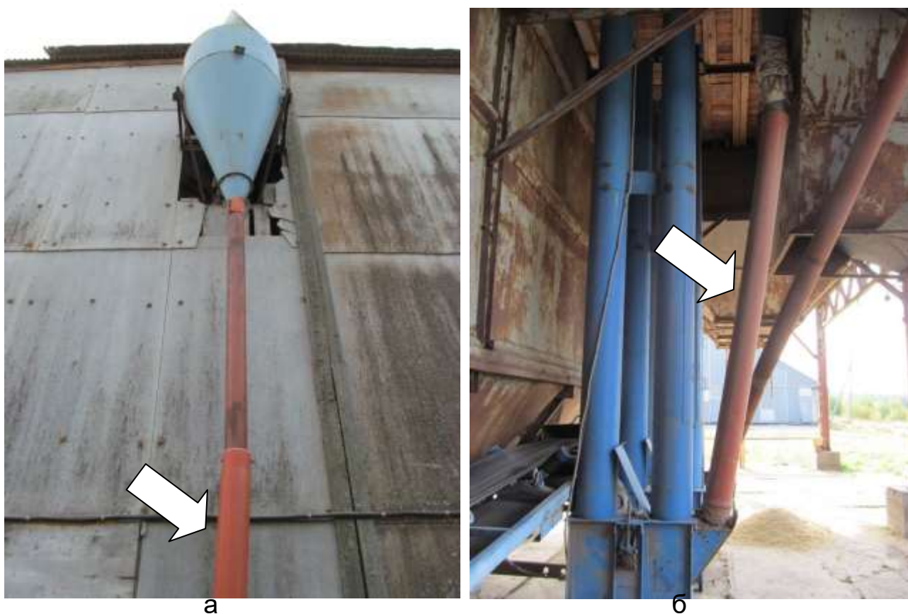
Рисунок 1 – Пример использования полимерных труб на вертикальном участке(а) и наклонном (б) в СПК к-з «Лекминский» Слободского района Кировской области
