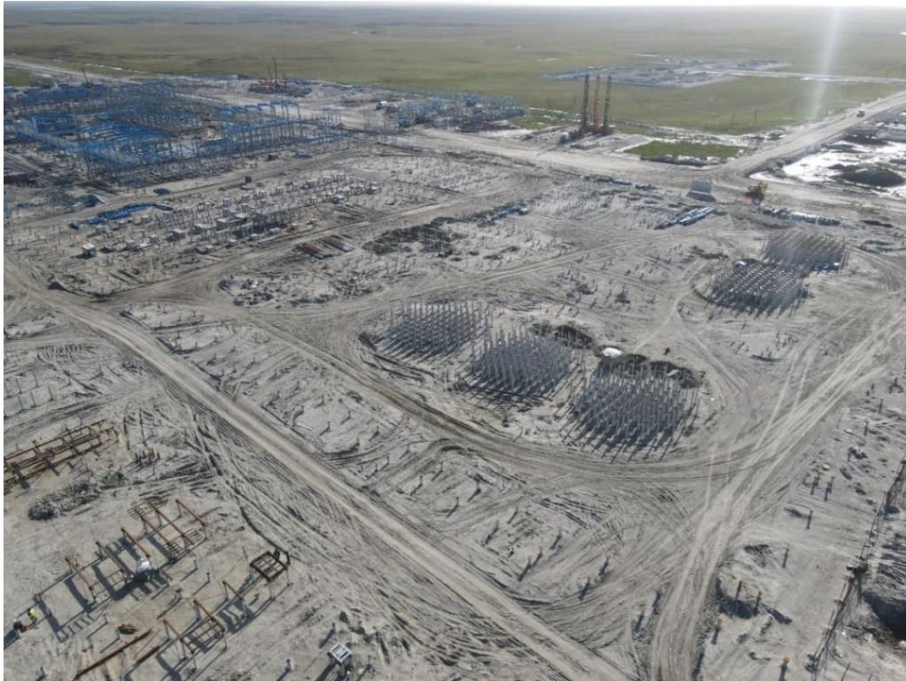
Рисунок 2. Обустройство свайных фундаментов
