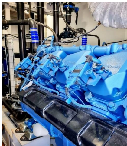
Рисунок 1 – Газопоршневой генератор
