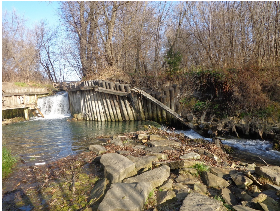
Фото 1. Существующее состояние ограждающей дамбы на участке производства работ
