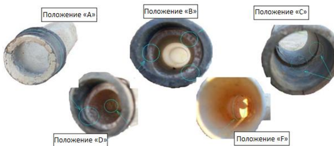
Рисунок 2 – Механические загрязнения на отдельных участках молокопровода
