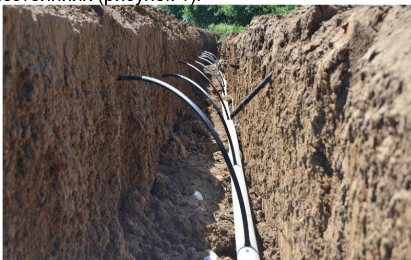
Рисунок 1– Подземное капельное орошение
