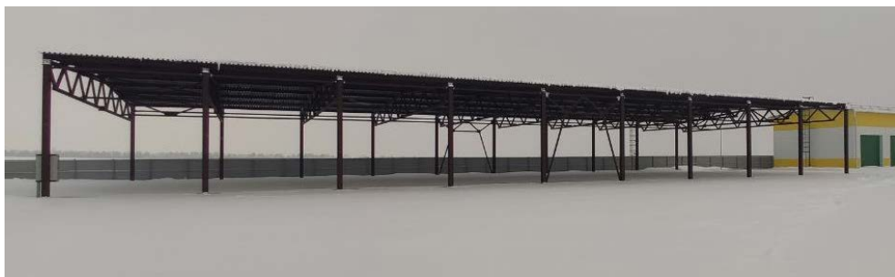
Крытая площадка для хранения сельхозтехники
